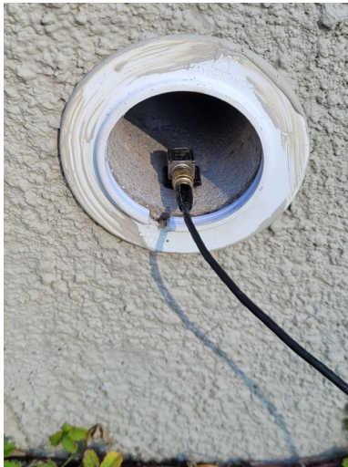
Figur 2 Accelerometerns fästpunkt i yttervägg mot källarum.
