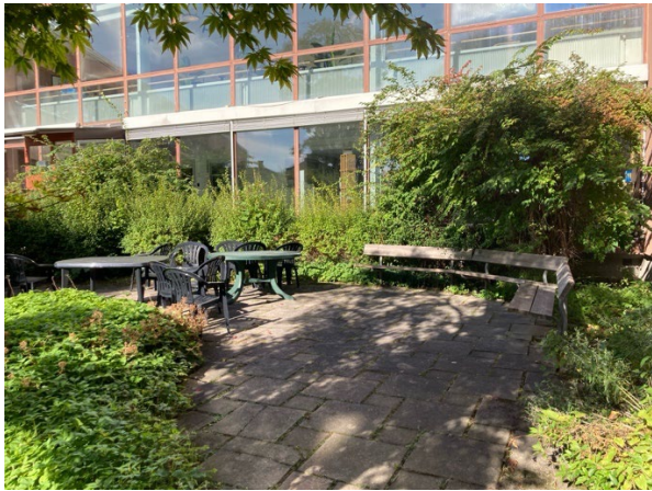
Figur 34 a: Vistelseyta med markbeläggning av betongplattor.
