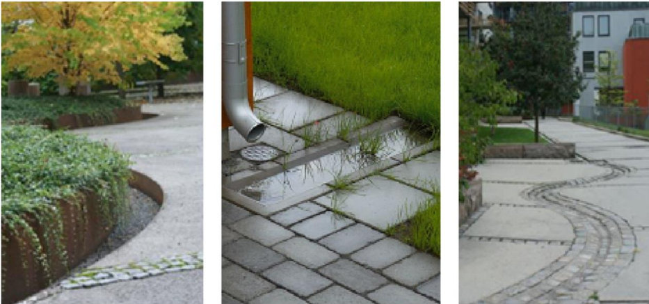
Figur 17. Exempel på utformning av dagvattenrännor i urban miljö. (Det högra och vänstra exemplet är foton från Sweco, exemplet i mitten kommer från S:t Eriks rännalsplattor)
