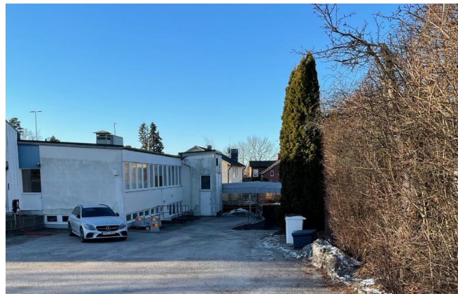
Figur 13: Nedfart till garage och källare inom planområdet.
