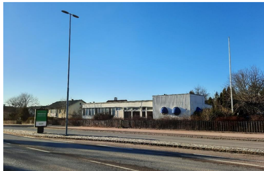
Figur 12: Byggnad inom planområdet sett från Köpingsvägen.
