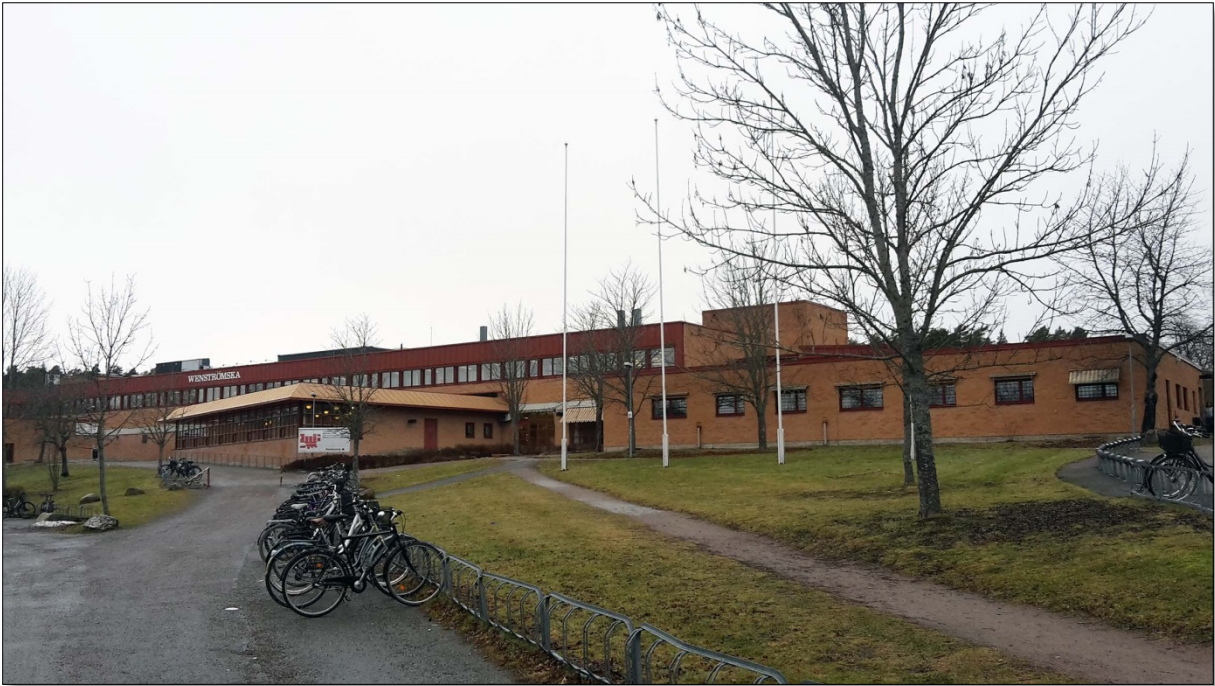
Wenströmska, vy från sydväst mot huvudentré A-byggnad och matsal (Stadsbyggnadsförvaltningen)
