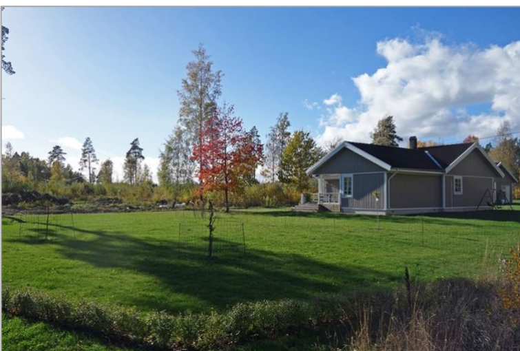
På den västra sidan av vägen mot Irsta kyrka ligger en omkring trettio år gammal villa som nyligen genomgått en totalrenovering. I bakgrunden skimtar det nu aktuella planområdet.
