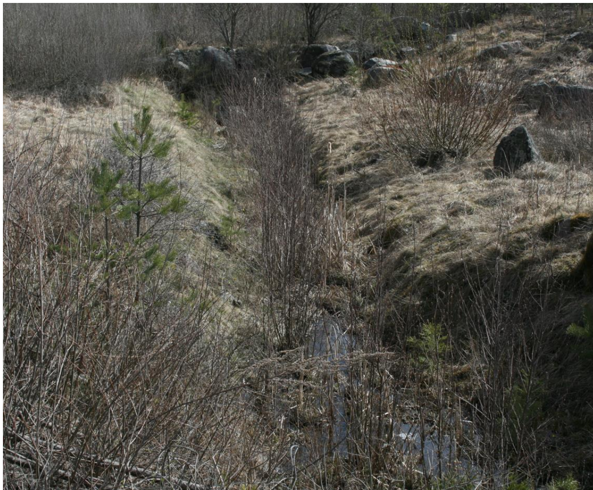
Figur 29 Vatten 3 bild i diket. Vy mot den äldre vägtrumman.
