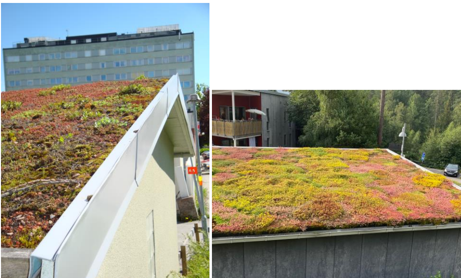
Figur 20. Exempel på gröna sedumtak på två mindre byggnader. Foto: Sweco.
