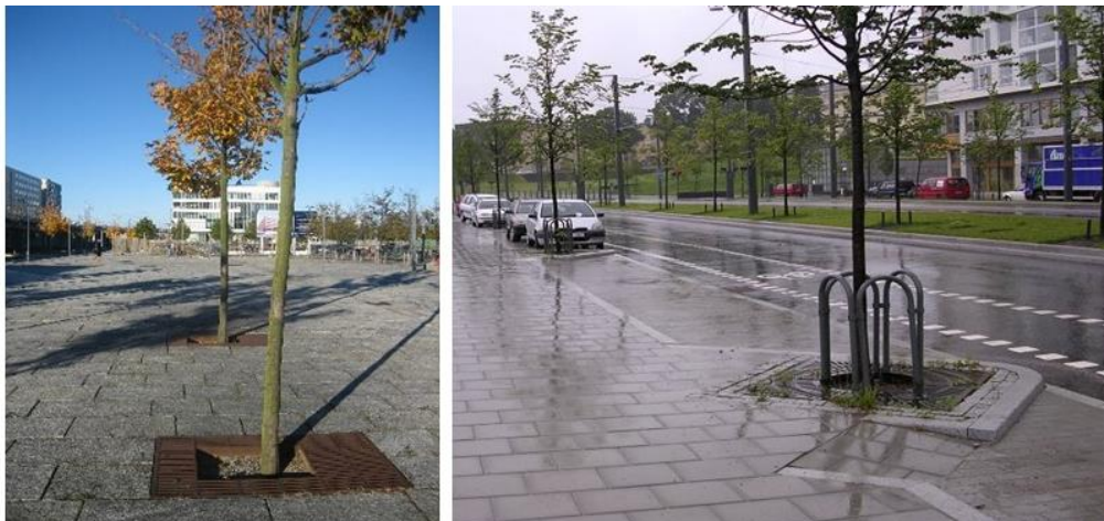
Figur 22. Exempel på trädplanteringar i skelettjordar vid torg och vid gata. Foto: Sweco.
