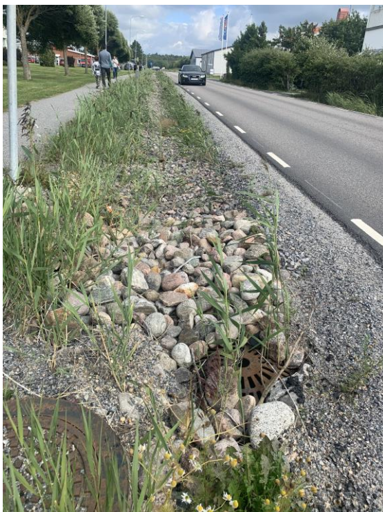
Figur 16. Exempelbild på ett makadamdike. Foto: Sweco.
