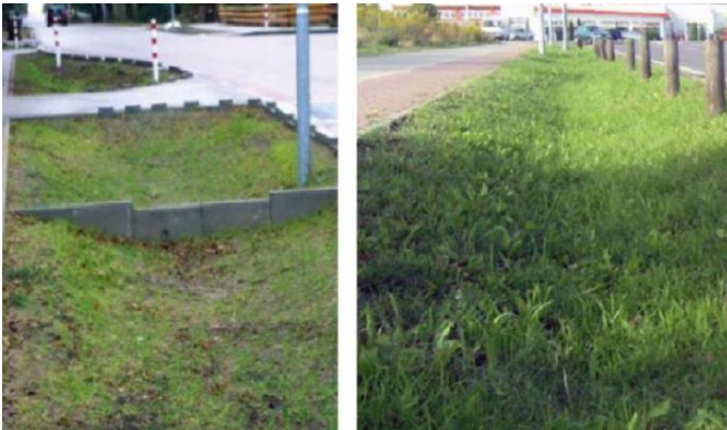
Figur 13. Exempel på hur gräsbeklädda diken kan utformas. Bilderna kommer från Stockholm Vatten och Avfall.
