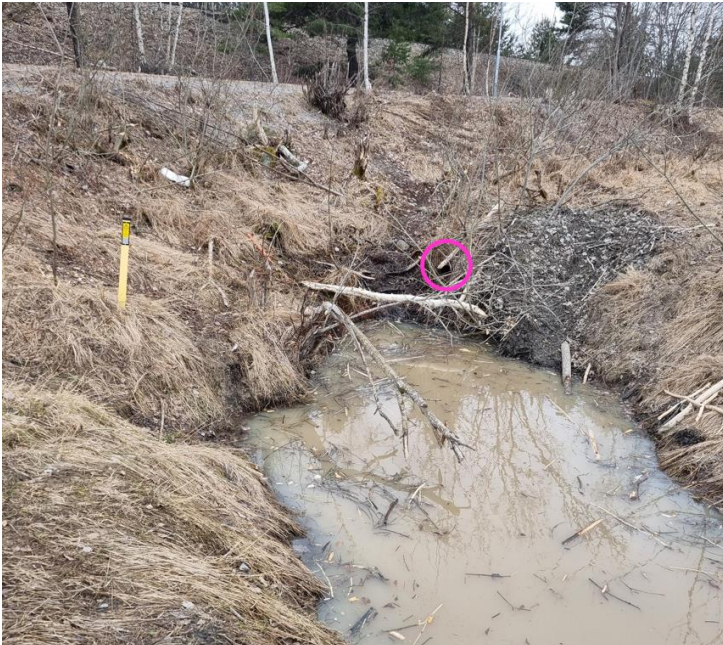
Figur 15. Dike öster om järnvägen. Rosa markering visar identifierad ledning (innerdiameter 200 mm).
