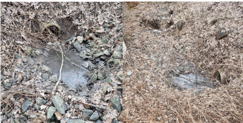
Figur 11. Utlopp (500 mm) från det tekniska avrinningsområdet väster om Åsenlundsvägen.
