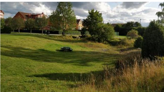
Figur 23. Exempel på torrdamm. Foto: Sweco.
