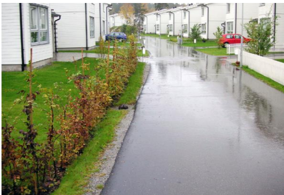
Figur 22. Exempel på utformning av makadamdike i bostadsområde.
