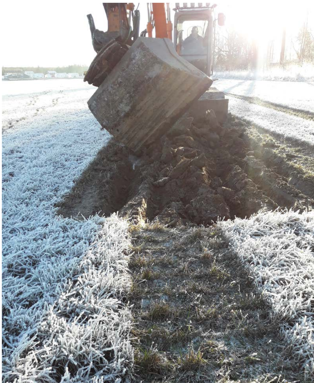
FIGUR 3. Den övre delen av matjorden var frusen och var tvungen att avlägsnas innan sökschaktning kunde ske ner till anläggningsnivå. Foto mot S. Foto Kerstin Westrin, SAU.
