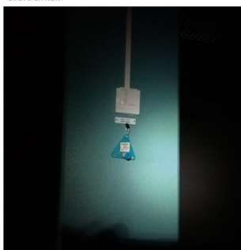
Figur 4. MP3, f.d. serverhall. Mätaren hänger på en pelare i rummets norra del.
