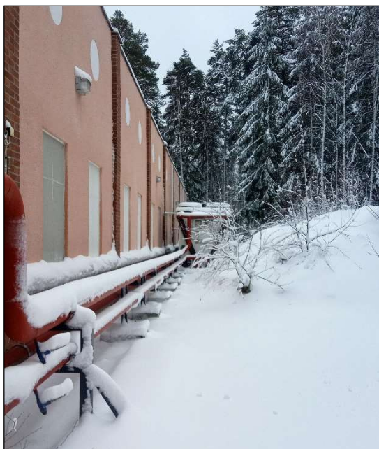
22TF11. Provgropen kunde inte grävas då det gick en kabelmatta längs fasaden och var brant slänt/berg utanför.
