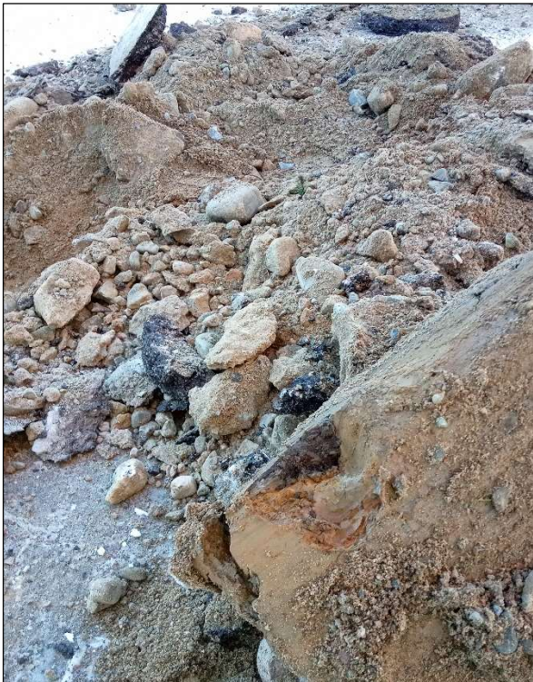
22TF09. I bakgrunden asfaltsbilar och bärlager. I förgrunden bedömt naturlig rödaktig siltlera med mörka inslag (gamla växtdelar).
