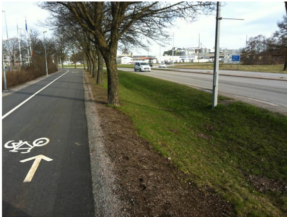
Figur 9. Svackdike mellan gata och gång- och cykelbana. (WRS, 2019)
