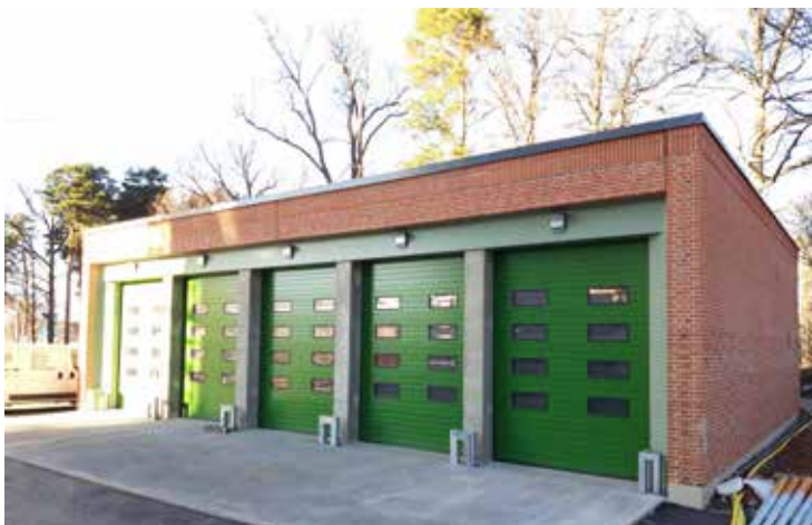
Sopsugsbyggnad på Öster Mälmarstrand är ett exempel på en omsorgsfullt gestaltad servicebyggnad.
