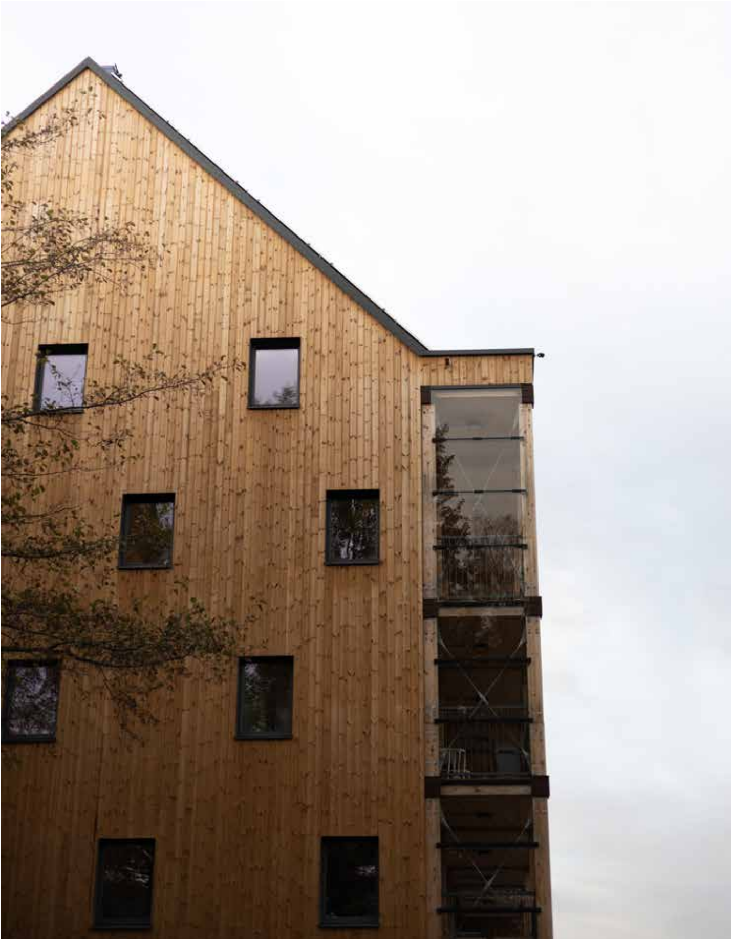
Solpaneler integrerade i balkonger.
