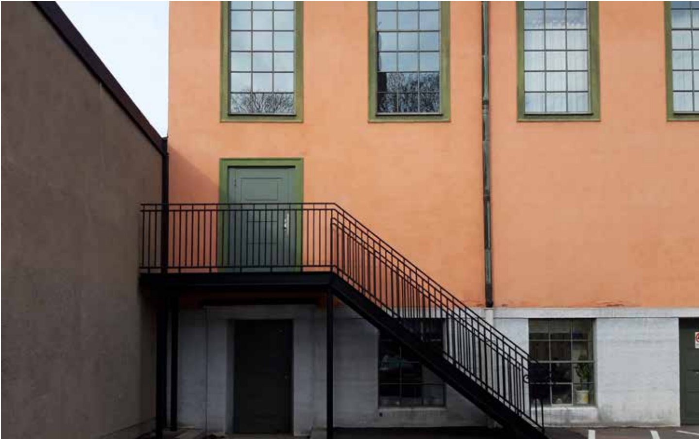
Bilden visar en ny brandutrymningsväg på Rudbeckianska gymnasiet gymnastikhall som fick en enkel men anpassad utformning.
